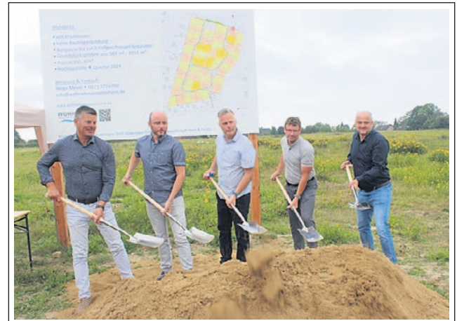
Am Dienstag erfolgte der 1. Spatenstich in Zimkendorf.
